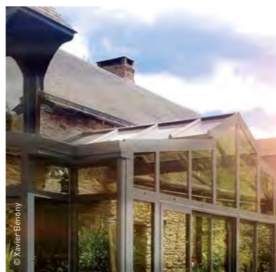
Chevron TOURMALINE, aspect visuel affleurant côté intérieur et en épinette côté extérieur.
