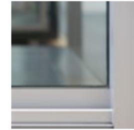
Détail extérieur du châssis : dormant-traverse basse
