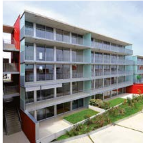
Architecte : Puig Pujol Photographe : B. Hanne
